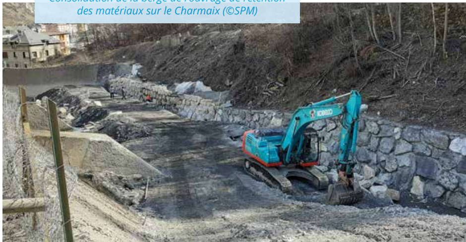
Consolidation de la berge de l'ouvrage de rétention des matériaux sur le Charmaix (©SPM)
