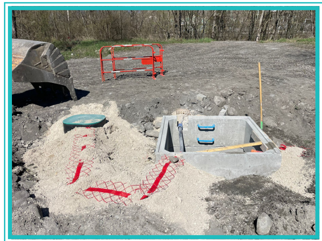
Travaux au Plein Sud
